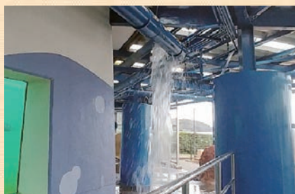
配管の破損による水漏れ
