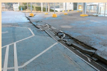
地震によってできたひび割れと段差
