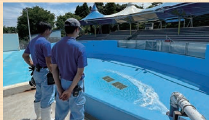
修繕後、初の注水テストの様子
